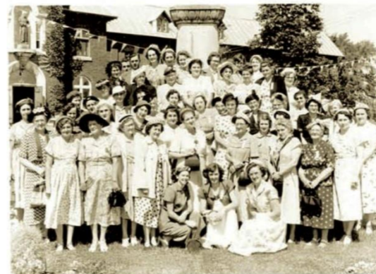
Cercle des Fermières de Sainte-Philomène Chapelle de la Réparation 1952
